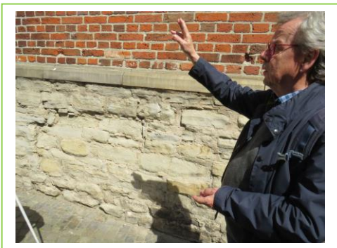
Der Sockel: Altenberger Sandstein.
